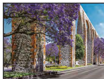
Calzada de los Arcos, Querétaro
